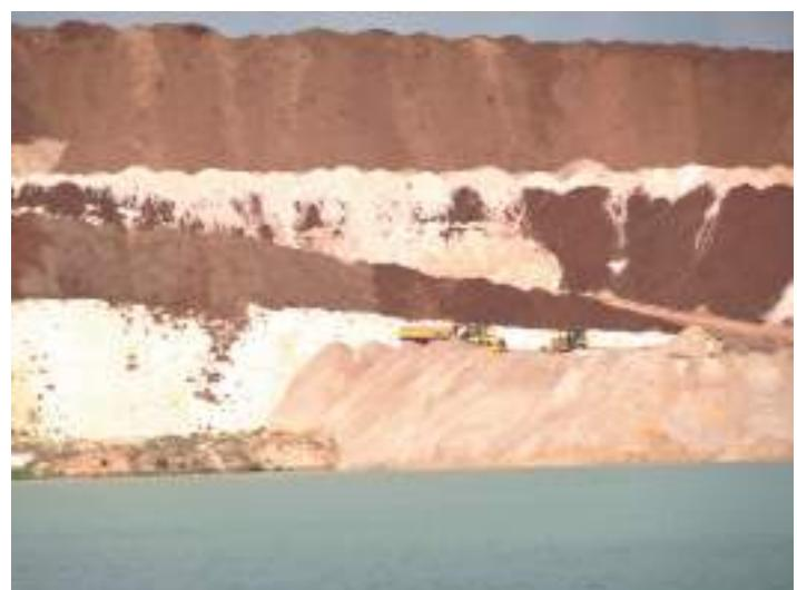
Фото 7. Засыпка отработанной части Южного карьера вскрышными породами
